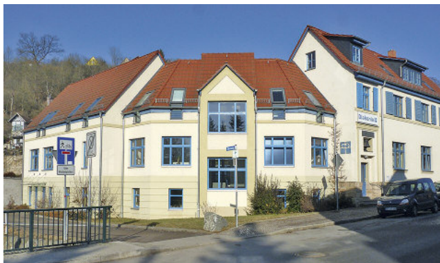
Neubau des Diakonie- vereins Rudolstadt e.V. in der Jenaischen Str. 1 an der Stelle der ehemaligen Rudol- städter Glockengießerei bzw. der Mayer'schen Maschinen- und Sprit- zenmanufaktur Foto: Jürgen Weyer, 2017
